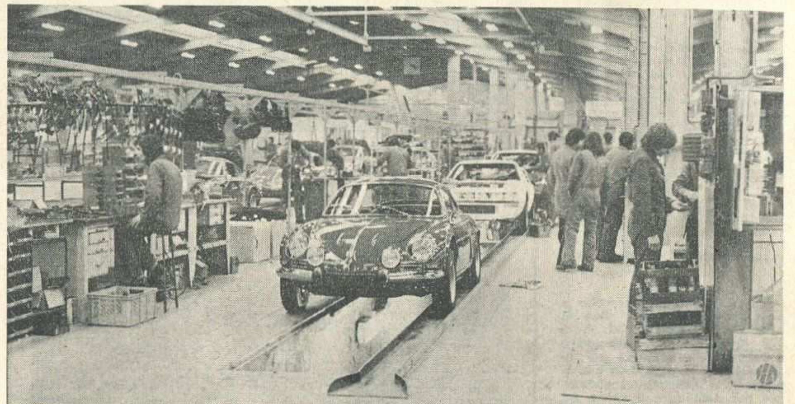
Qui sopra, una carrozzeria della A 310 in allestimento sull'apposita « maschera ». A destra, in alto le A 310 complete di scocca in attesa della finitura. La produzione attuale è di tre vetture al giorno. In basso, la catena di montaggio finale, nella quale coesistono le « vecchie » ma sempre valide A 110 e le nuove A 310
