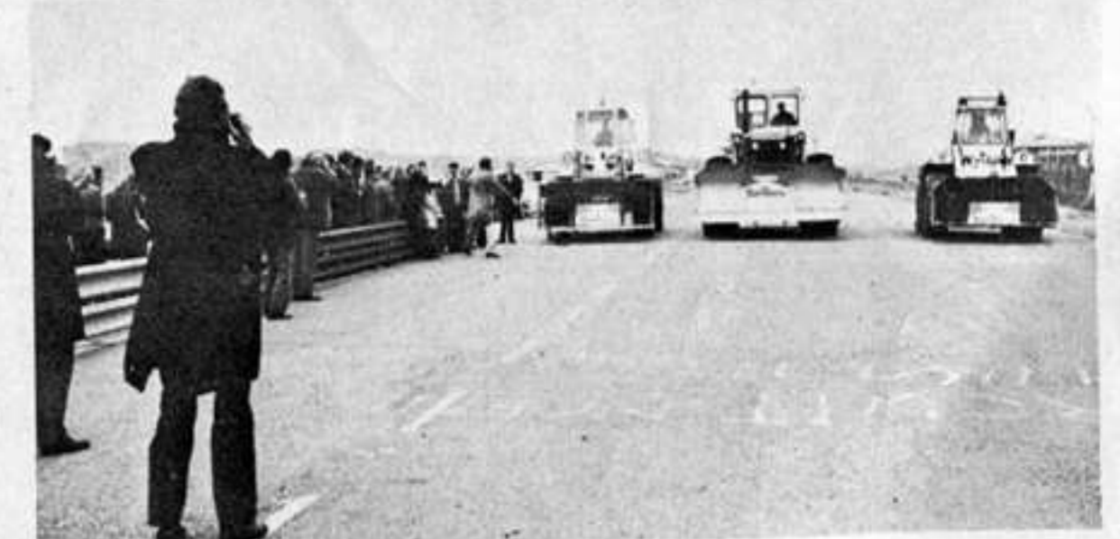
L'inizio simbolico dei lavori: scattano le ruspe con al volante Van Lennep, Hugenholtz e Wessel
