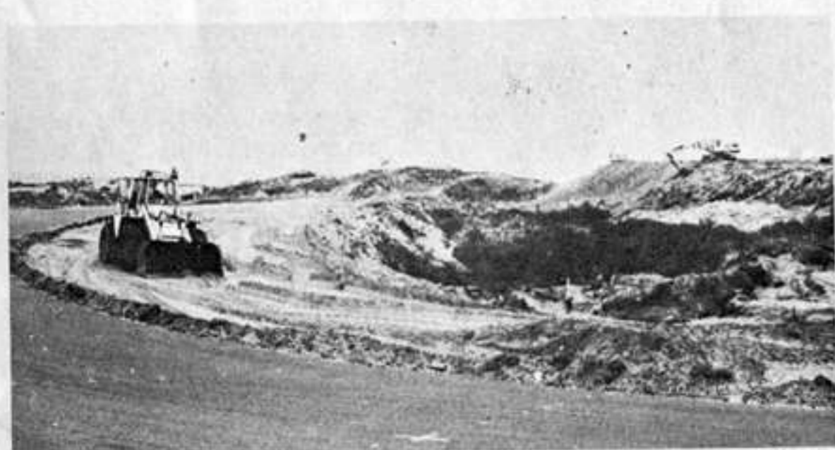
Un bulldozer all'opera a Zandvoort per « sbancare » i lati della pista e creare la fascia di emergenza
