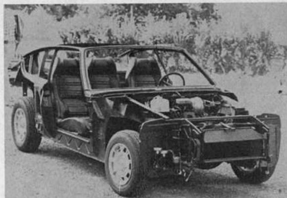
Sopra, un'immagine molto efficace della struttura portante della Bagheera. A destra, l'8 cilindri U-8
