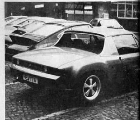
Ancora una vista, questa volta posteriore, della 916 con motore di 2400. Notare la forte bombatura superiore dei passaruota
