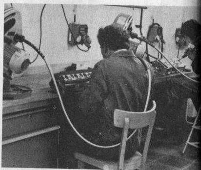
Due operai intenti alla finitura delle testate di unità 4 cilindri di 2 litri bialbero a 16 valvole
